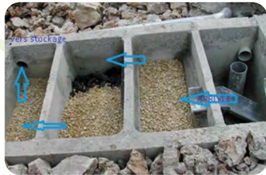
Figure 5 : Filtre à granulats et cheminement des eaux à filtrer
