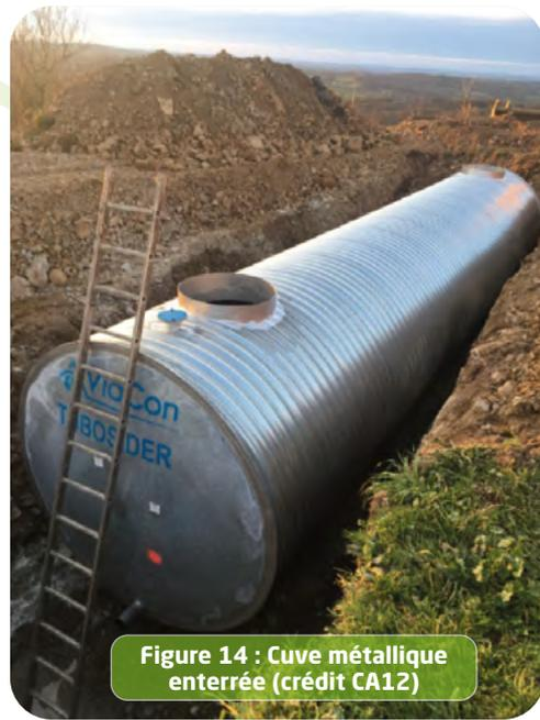
Figure 14 : Cuve métallique enterrée (crédit CA12)
