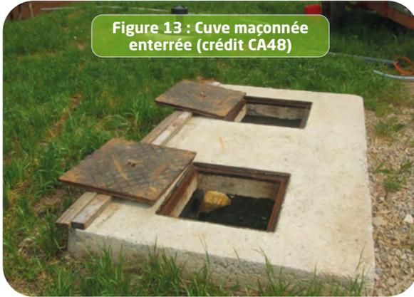
Figure 13 : Cuve maçonnée enterrée (crédit CA48)
